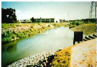
②鞍流瀬川 (大府市) 工事完了直後
