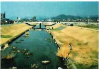
④新郷瀬川 (犬山市) 再生工事前
